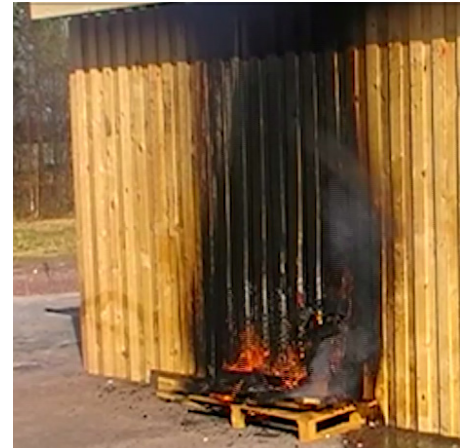
Fasaden är säkrad mot återantändning.
